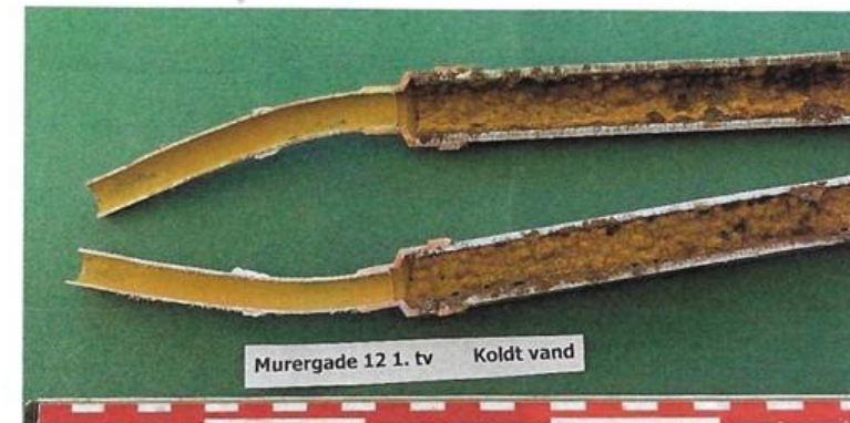
Figur 11 Muregade 12 1. tv, koldt vand vandsiden i rørprøve
